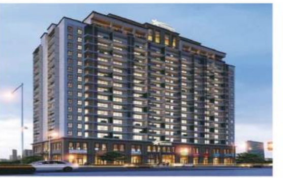
CÔNG TRÌNH STAR TOWER BÌNH DƯƠNG
