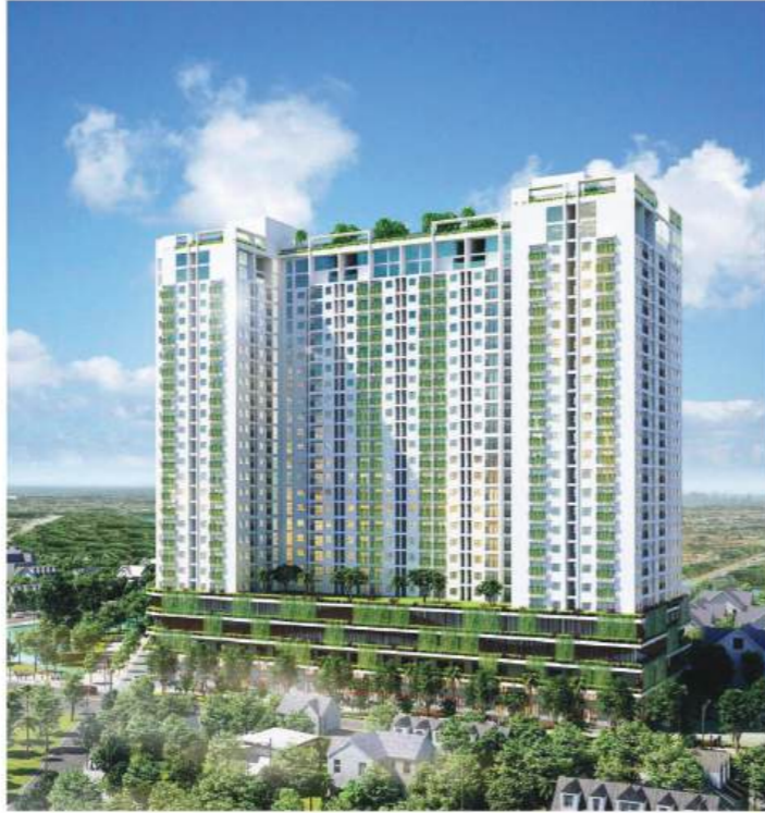
CÔNG TRÌNH ECOLIFE REVERSIDE - QUY NHƠN
